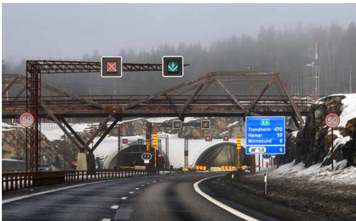
Trafikkomlegging ved Eidsvollstunnelen på E6 i Akershus. Foto: Knut Opeide
