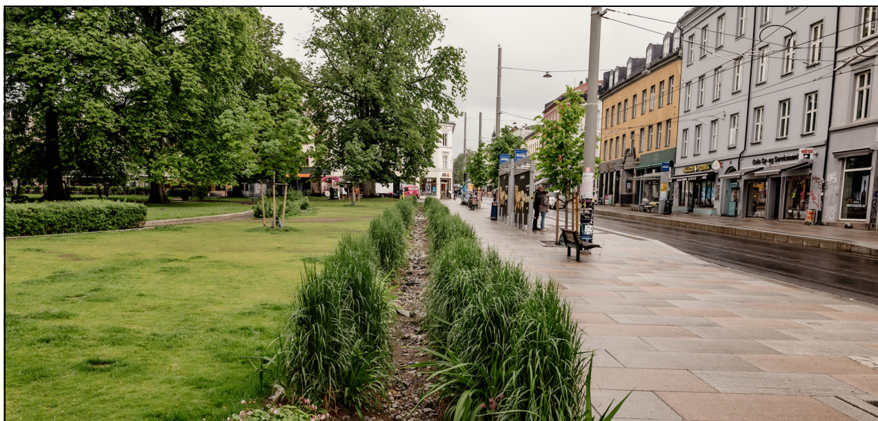
Figur 5.6 Overvannshåndtering i Thorvald Meyers gate.
