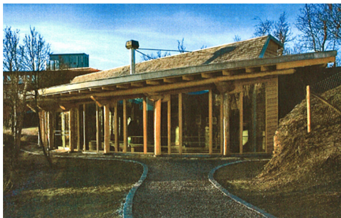
Fasade mot nord. Opphavsrett: Statsbygg.
