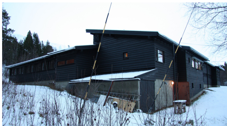
Hovedhusets fasader mot vest og sør. Opphavsrett: Statsbygg.
