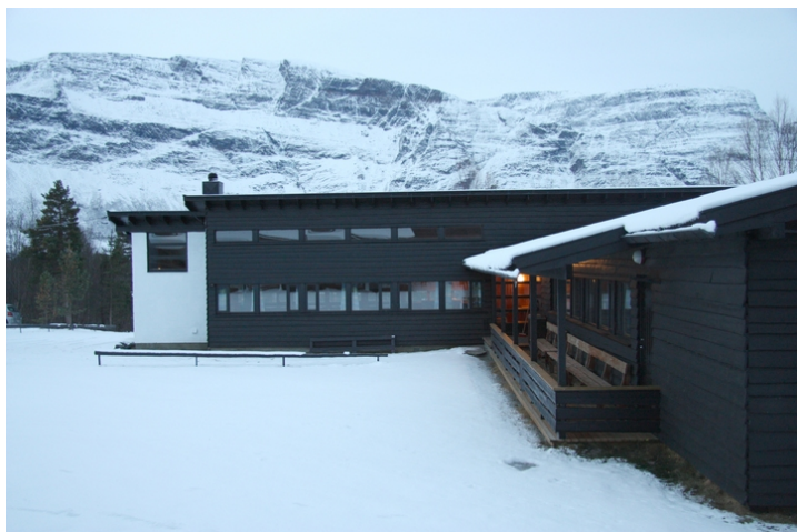
Hovedhusets fasader mot nord og øst. Spisesal i fløyen midt i mot. Opphavsrett: Statsbygg.
