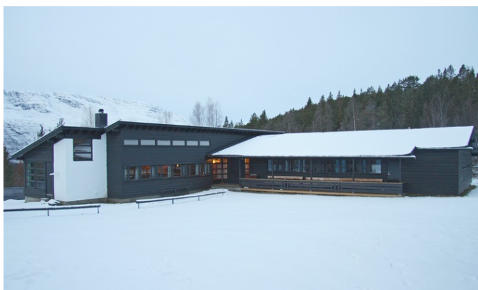
Hovedhus. Opphavsrett: Statsbygg.
