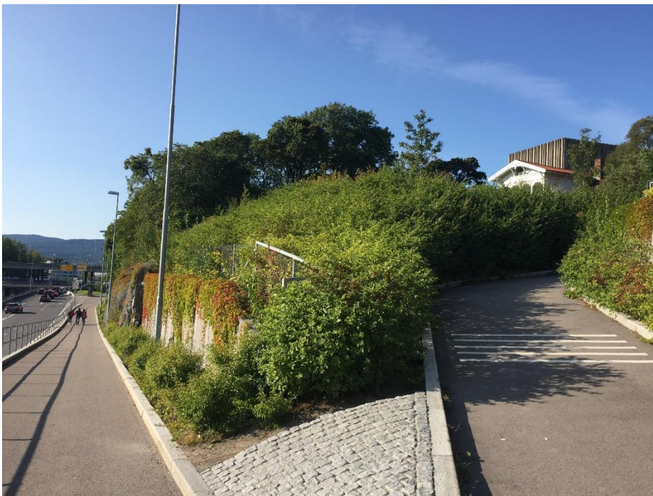
Figur 31. Trondheimsveien i bakgrunnen
