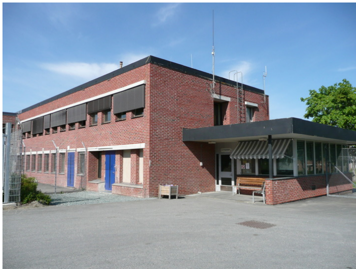
Inngang sentralvakt. Opphavsrett: Statsbygg.
