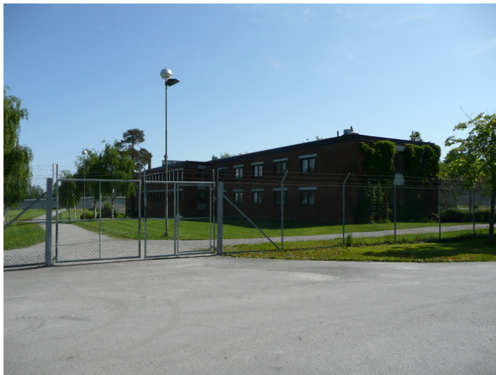
Fasade fra nordvest. Opphavsrett: Statsbygg.
