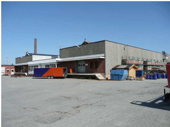
Fasade sørvest. Opphavsrett: Statsbygg.
