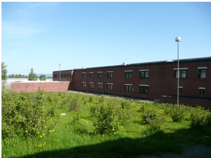
Fasade fra sydvest. Opphavsrett: Statsbygg.
