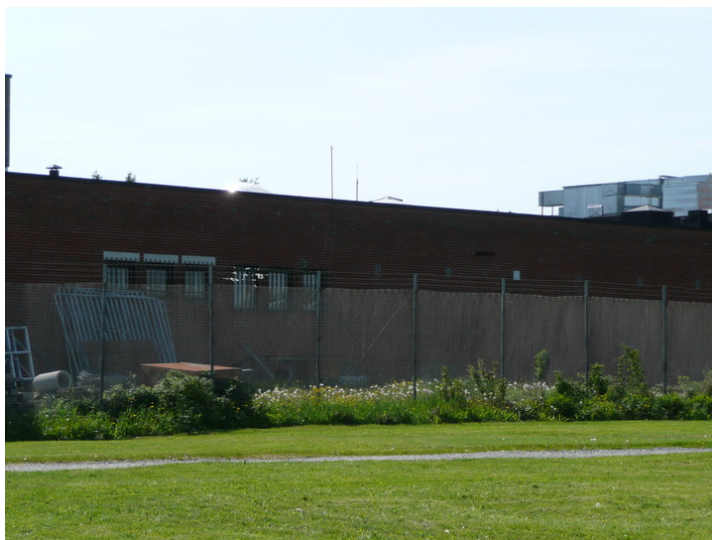
Fasade mot nordvest. Opphavsrett: Statsbygg.
