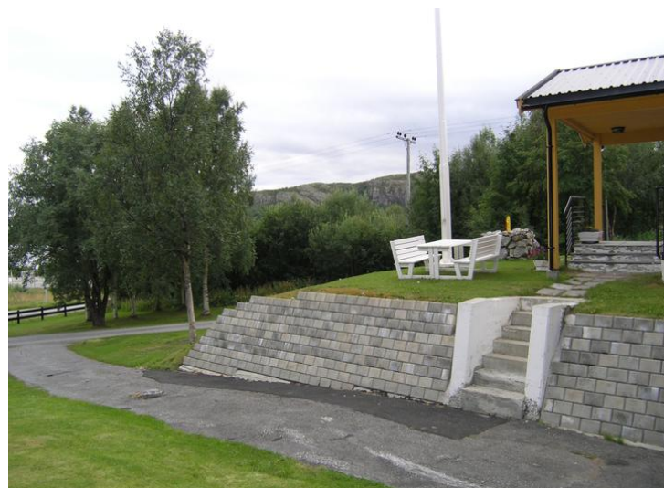
Adkomstområdet. Opphavsrett: Statsbygg.
