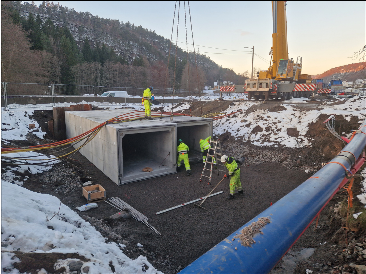
Figur 4.4 Statens vegvesen utbetrar veg og installerer to store kulvertar i Kristiansand.
