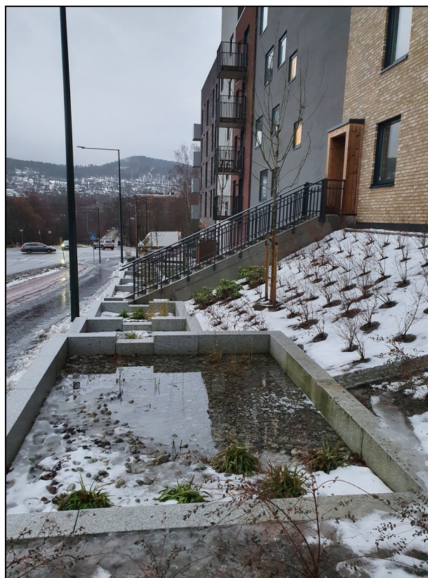
Figur 11.5 Regnbud for infiltrasjon og fordryging av overvatt. Frysja, Oslo.
