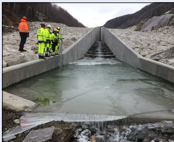
Figur 7.9 Botnlastsperre ved Kvam i Nord-Fron kommune som består av ein damterskel av lausmassar, ein gjennomløpskanal og eit basseng i betong.
