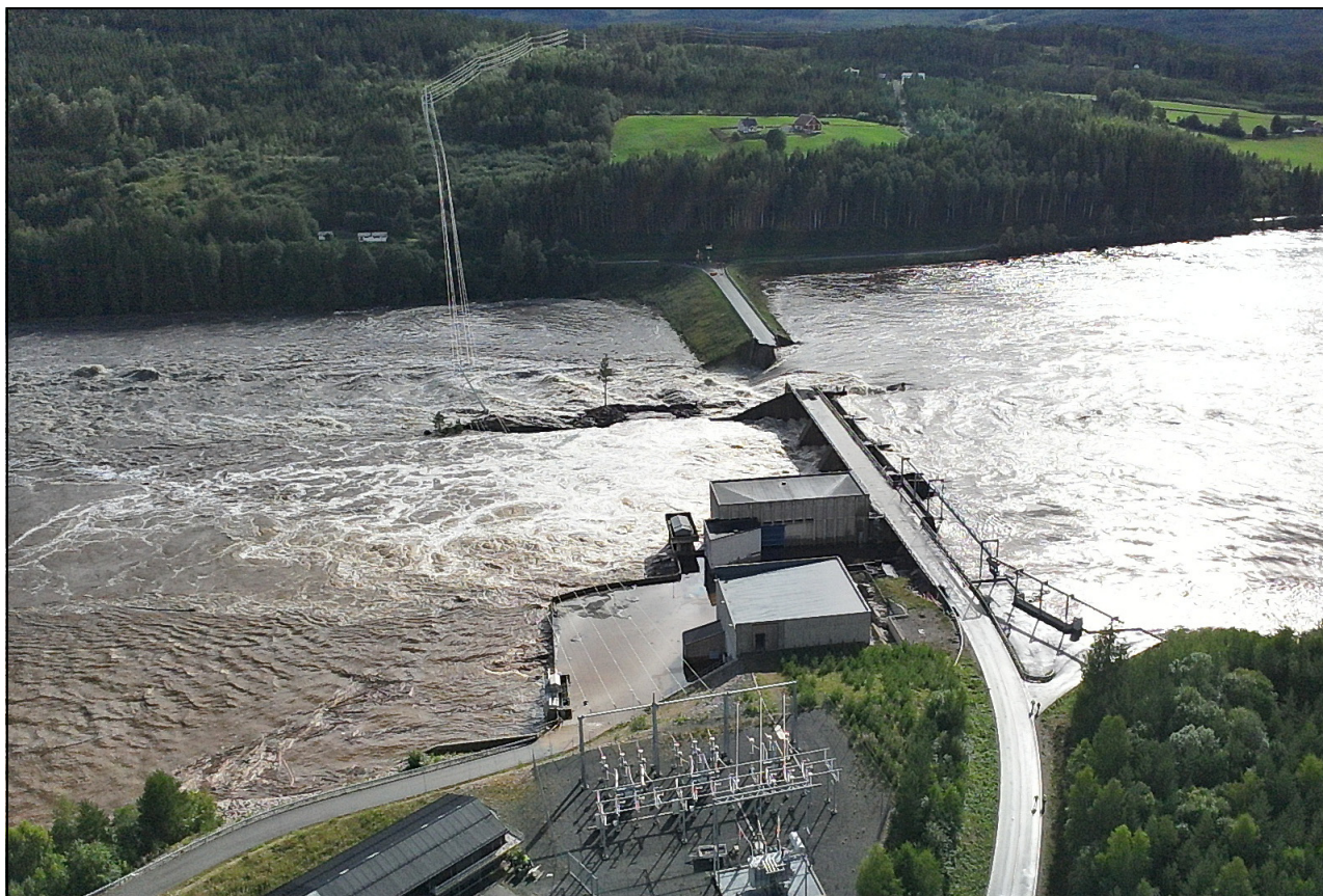
Figur 12.5 Dambrot på Braskereidfoss kraftverk under ekstremvêret Hans i 2023.
