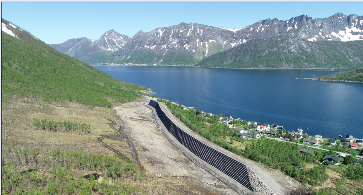
Figur 7.11 Oversiktsbilde av fangvollen i Fjordgård i Senja kommune.
