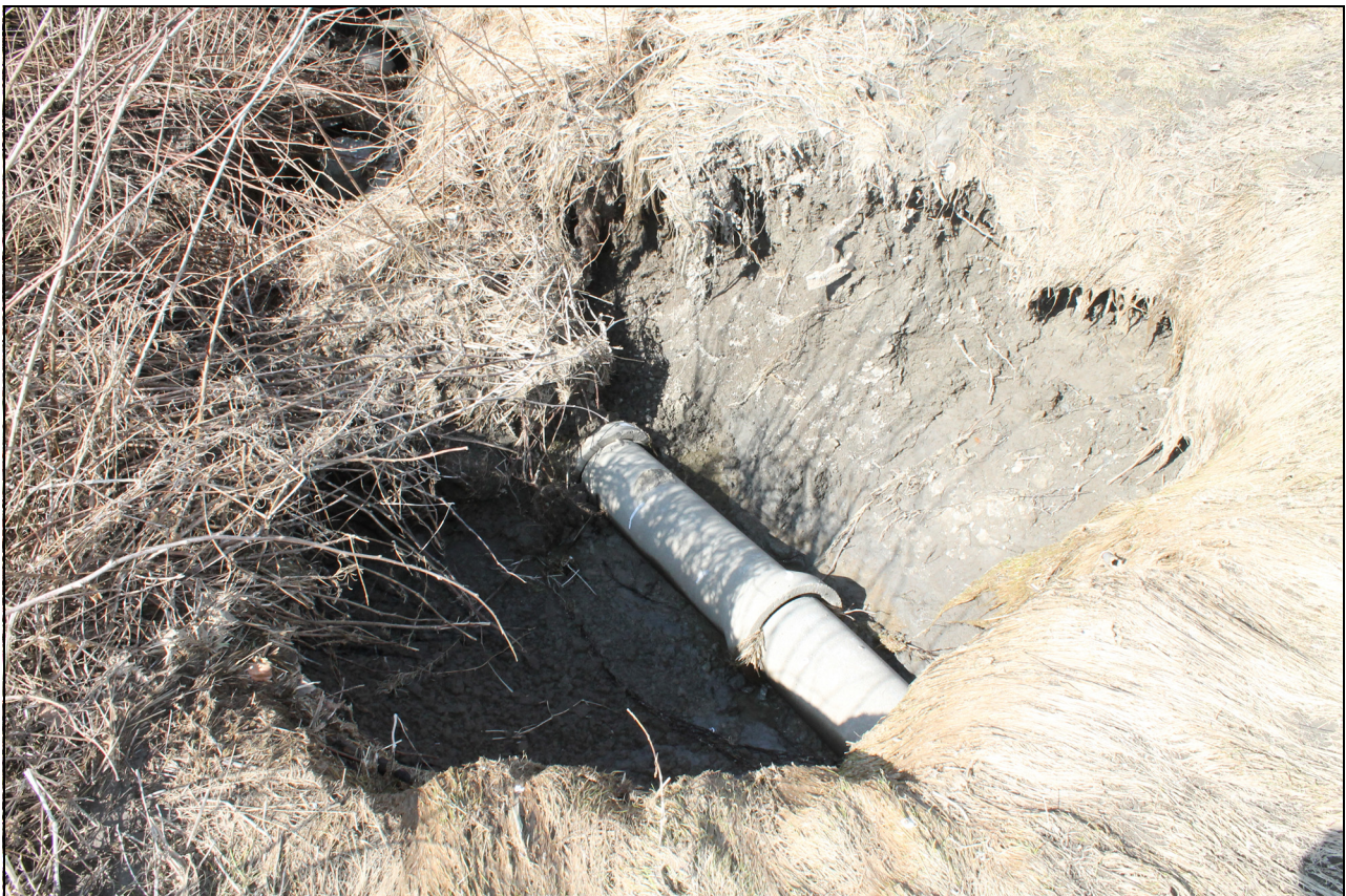
Figur 13.3 Erosjonsskadar i bekkelukka kanalar i eit planert jordbruksområde.
