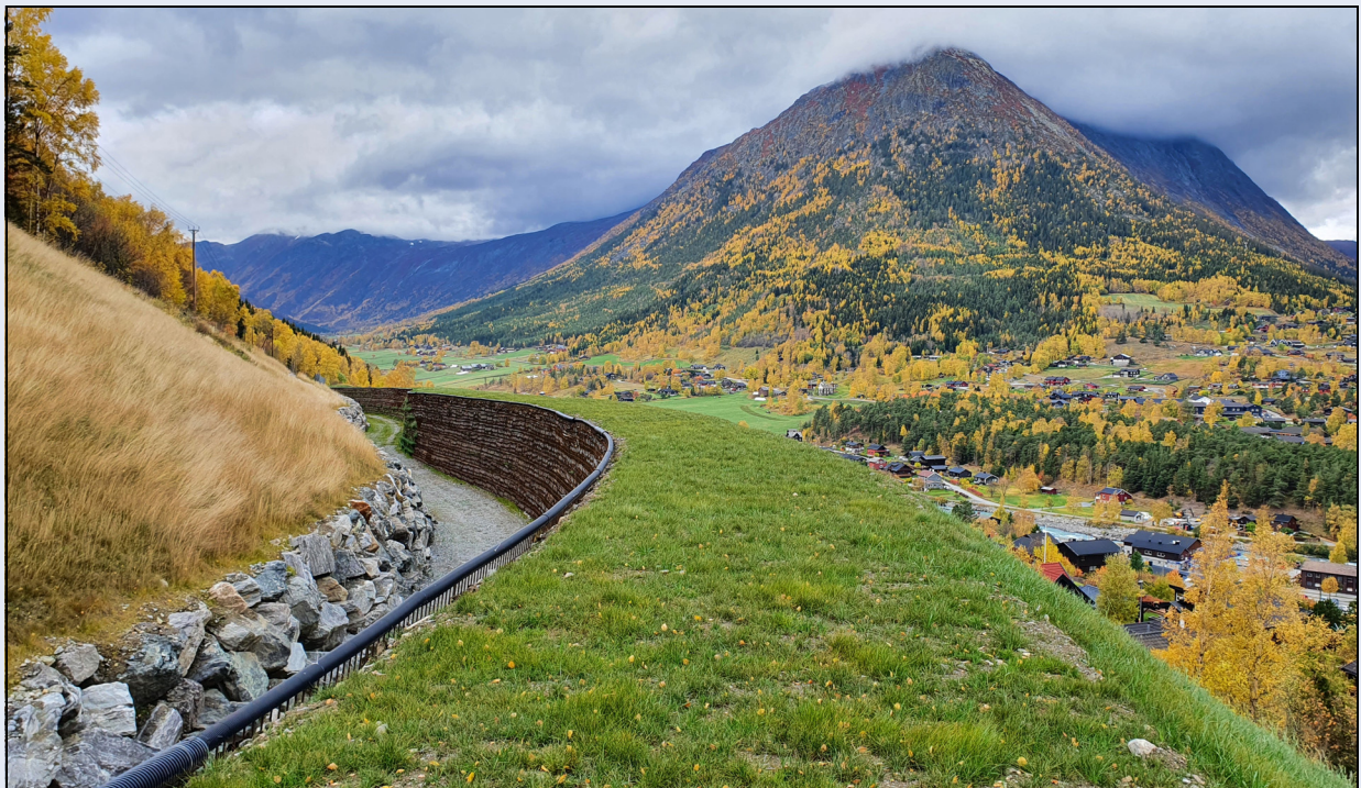
Figur 7.7 Skredvollen og fanggrøfta over Ulstad, Lom kommune.
