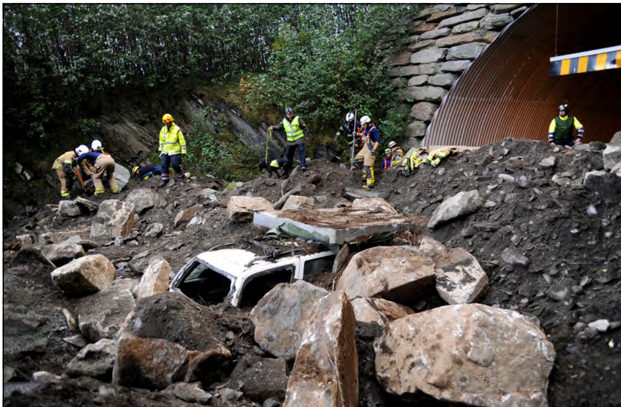
Figur 10.3 Øvelse jordras ved tunnel
