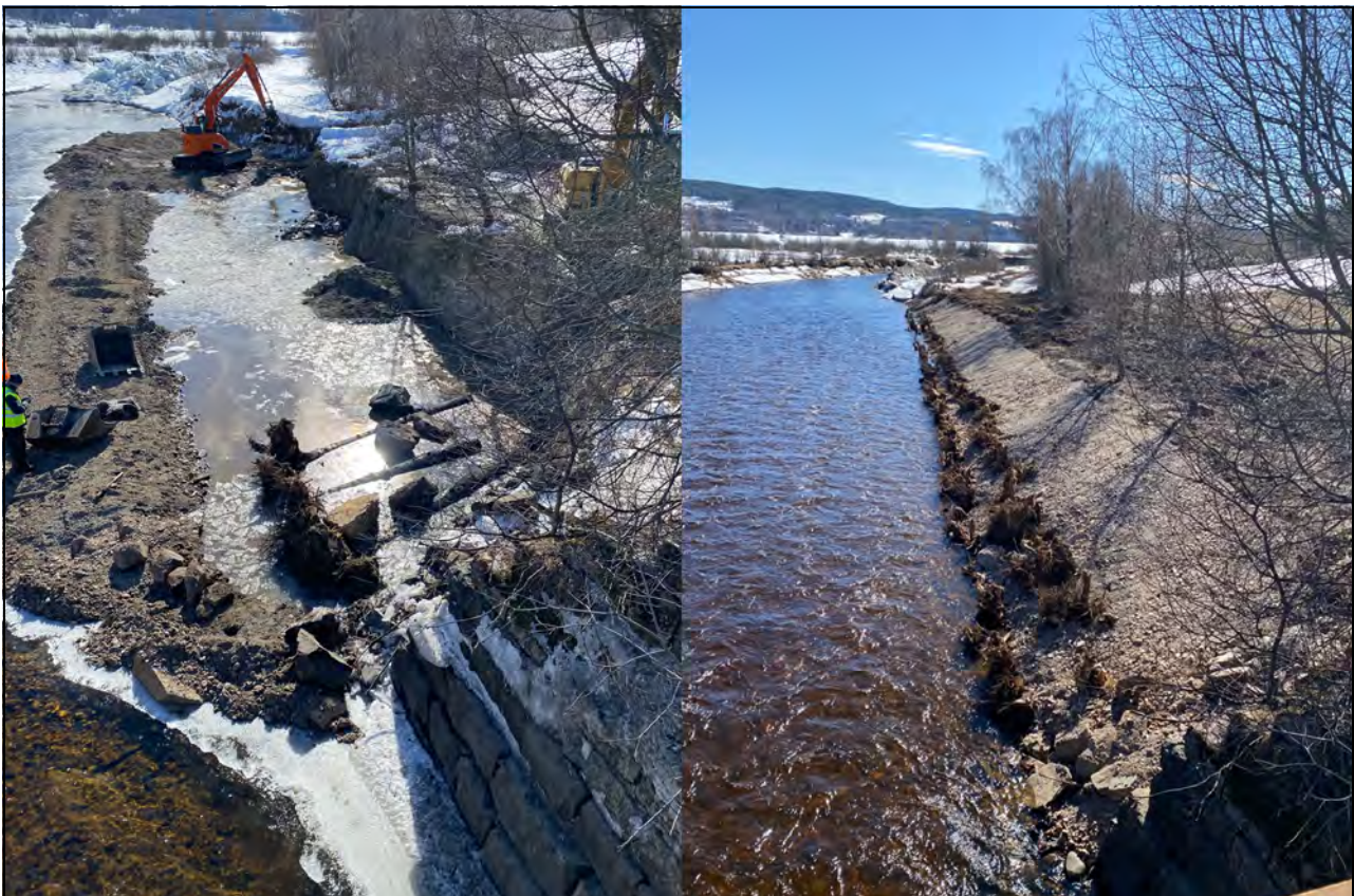
Figur 4.2 Naturbaserte løsninger – stabilisering av bekkekant mot erosjon
