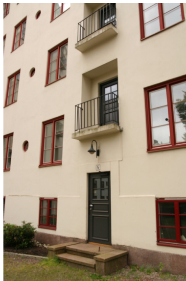
Utgangsdør mot bakgård med balkong fra baktrapp over. Vinduene er nye, de små runde vinduene er originale. Opphavsrett: Statsbygg.
