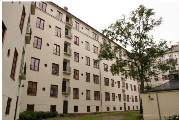
Fasade mot bakgården som omkranser Frogner kirke. Opphavsrett: Statsbygg.
