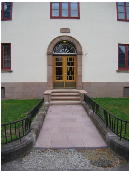
Inngangsparti med granitt detaljer som trolig er spesialtegnet av arkitekt Ree. Opphavsrett: Statsbygg.
