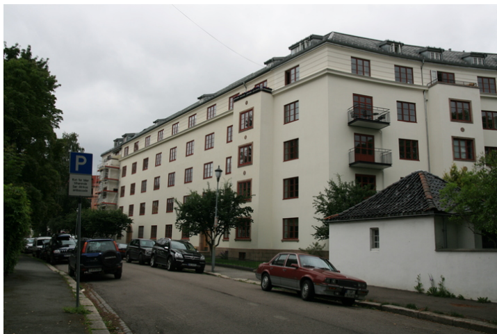
Gimle terrassen 5 og 7, hovedfasaden mot sør. Nummer 5 er nærmest i bildet. Opphavsrett: Statsbygg.
