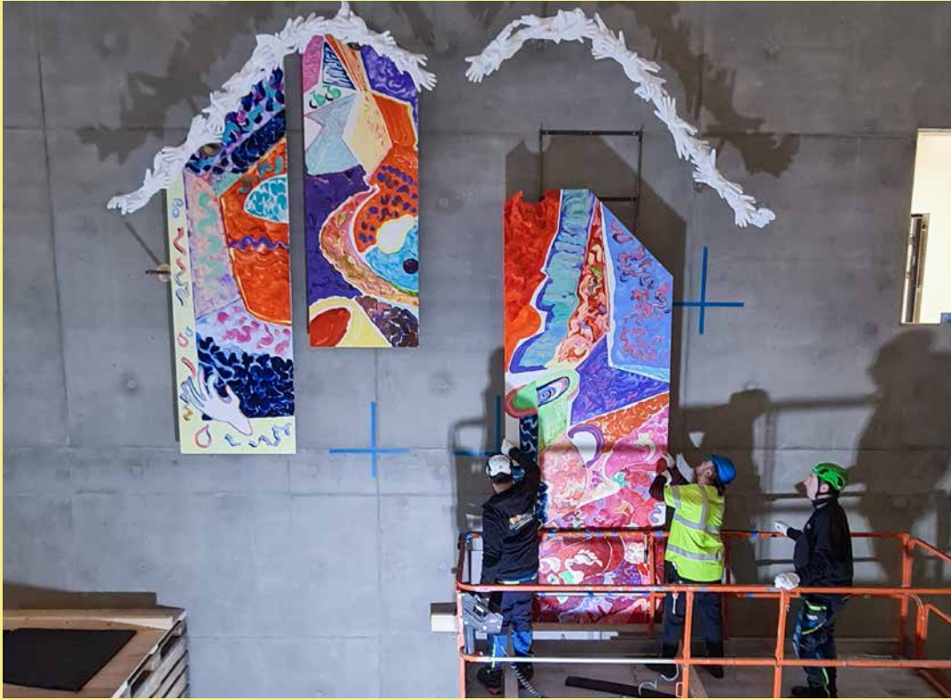
Montering av DOMESTISISME (Medaljong) av Ida Følling Madsen og Markus Li Stensrud, på Evenes flystasjon. Foto: Markus Li Stensrud.
