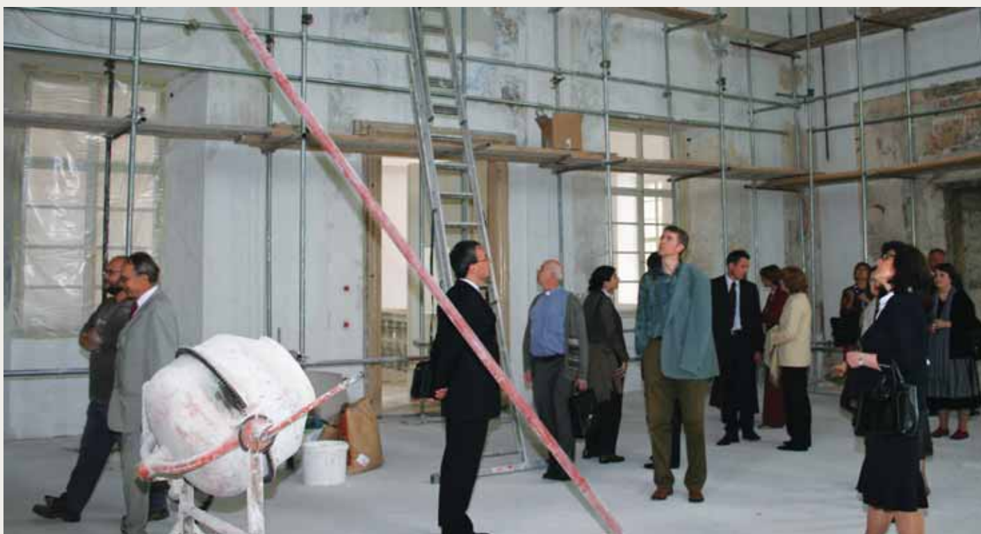
Barokksalen som ble oppdaget under restaureringsarbeidet er hele 12 meter under taket.
