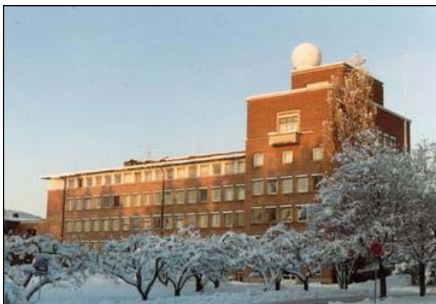
Meteorologisk institutt på Blindern, Oslo. Oppført i perioden 1936-1940.
