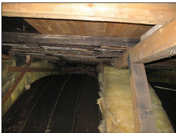
Bilde 4: Isoleringen av selve hvelvet og betongdragerne som ble gjennomført etter brannen i 1975
