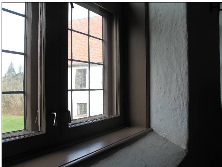
Bilde 6: Typisk vindu i utstillingslokalet. Utettheter kan bidra til kondensutfelling av vann.
