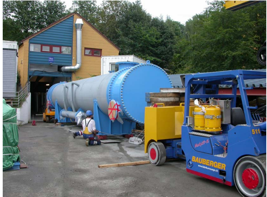
Viken Fjernvarme, Skøyen varmesentral - Inntransport av varmepumpe, oktober 2005
