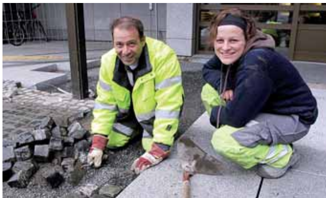
Alexandros Vasilaras og Mirjann Østgård skifter ut deler av brusteinen med tettliggende heller for å bedre framkommeligheten til rådhuset i Gjøvik.
