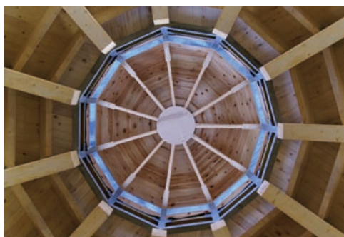
Detalj fra taket i det nye fjøset
