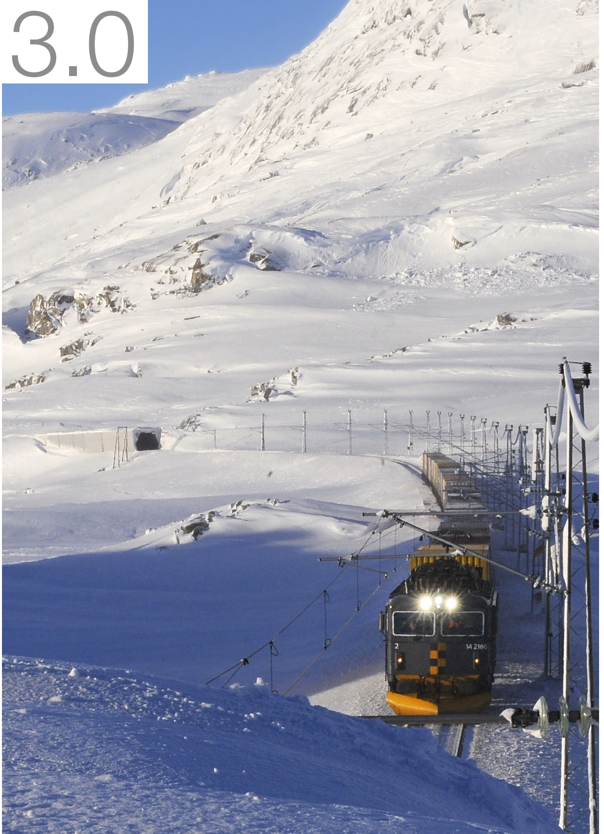
Cargonet – Bergensbanen Foto: Jernbaneverket
