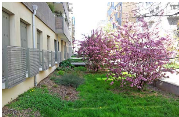
Regnbed i Billancourt, Paris. Foto: Dronninga landskap
