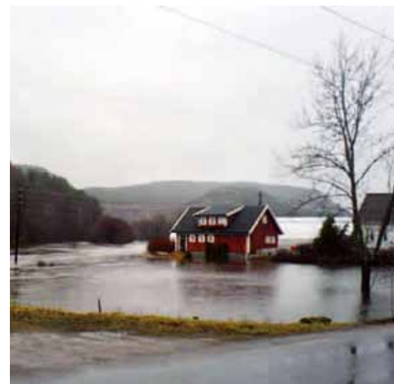
UNDER VANN. Store nedbørsmengder gjorde at Søgneelva gikk over sine bredder denne uka. Nå strømmet skademeldingene inn.
