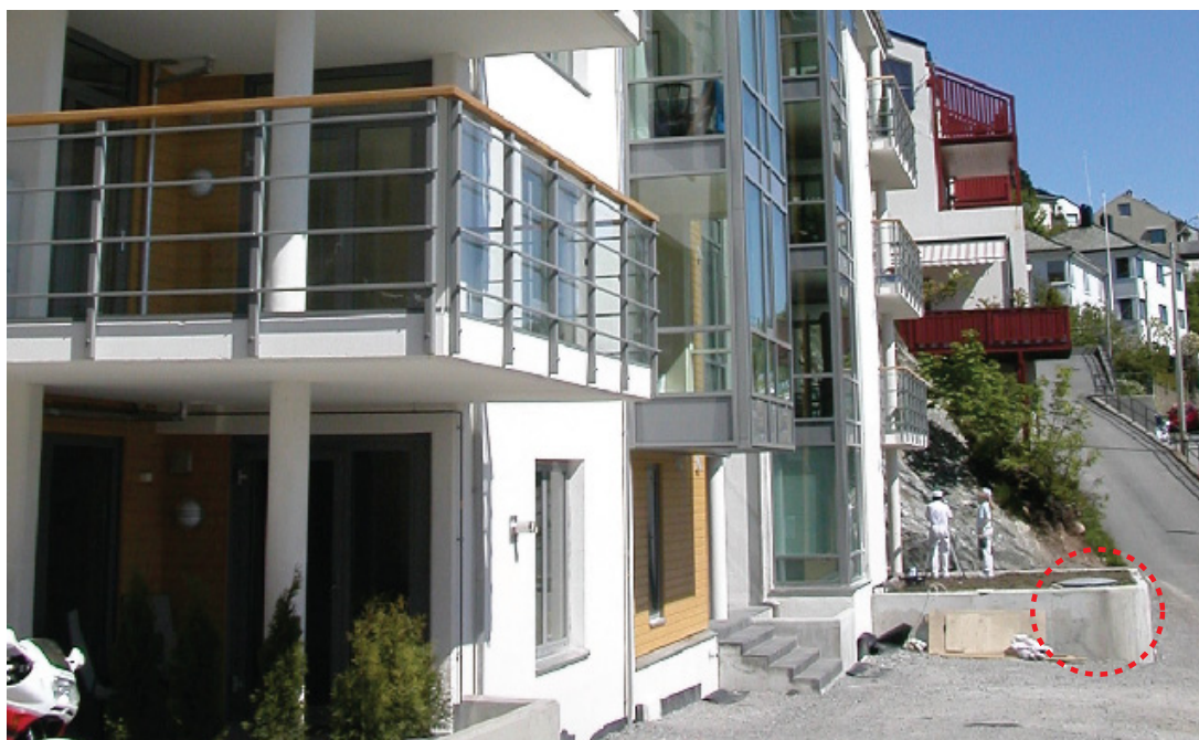
Figur 14.1 Bilde som viser gasstankens plassering. Gasstanken var plassert under bakken, nedgravd i en betongkrybbe i forkant av bygningen. Sirkelen viser tankens plassering.
