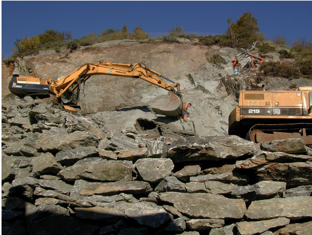
Figur 6.9 Bilde fra sprengningsarbeidene på Fjelltunvegen 31 Fotograf: Steinar Trygstad
