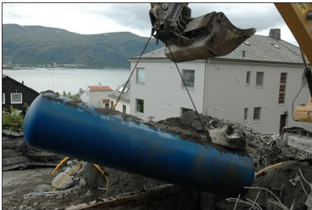
Figur 14.2 Heving av gasstanken Gasstanken ble ikke skadet. Her heves den etter at bygningen er revet. Foto: Ørjan Svendsen, DSB
