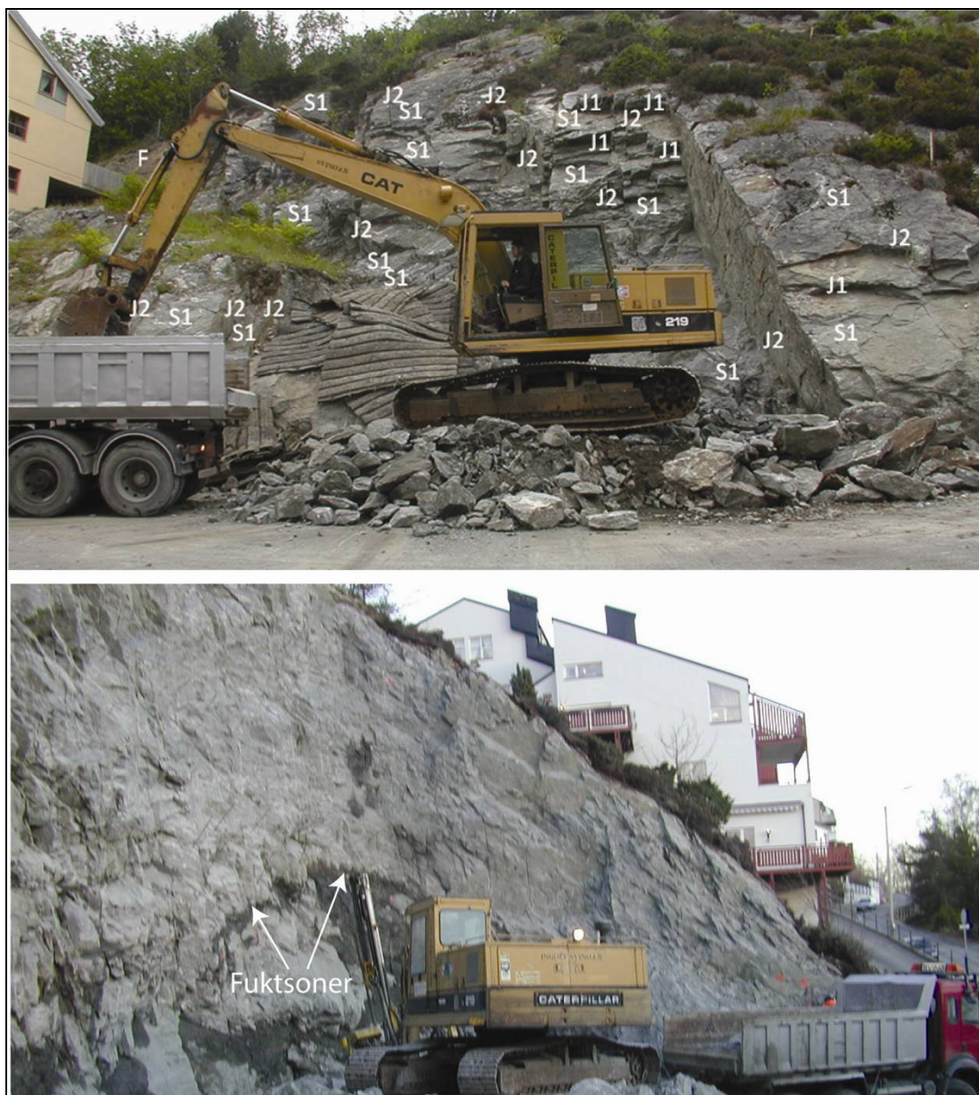
Figur 5.9 Bilde under utsprenging i Fjelltunvegen
