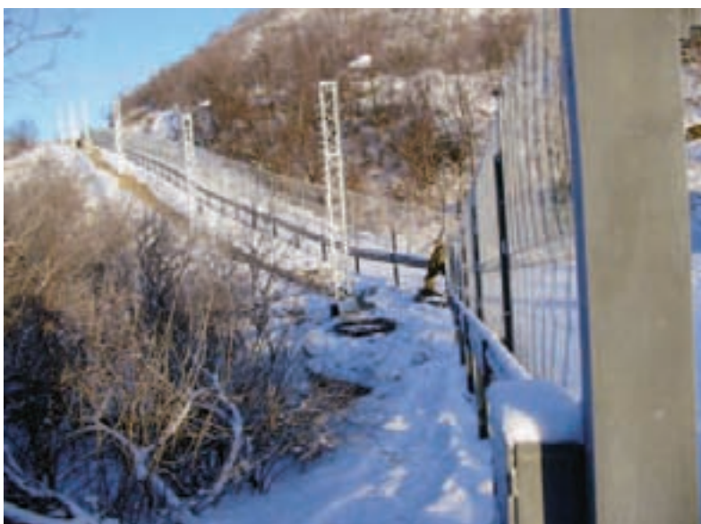
Норвегия финансировала работы по защите этого района губы Андреева ограждением и системами сигнализации. Фото: администрация губернии Финнмарк
