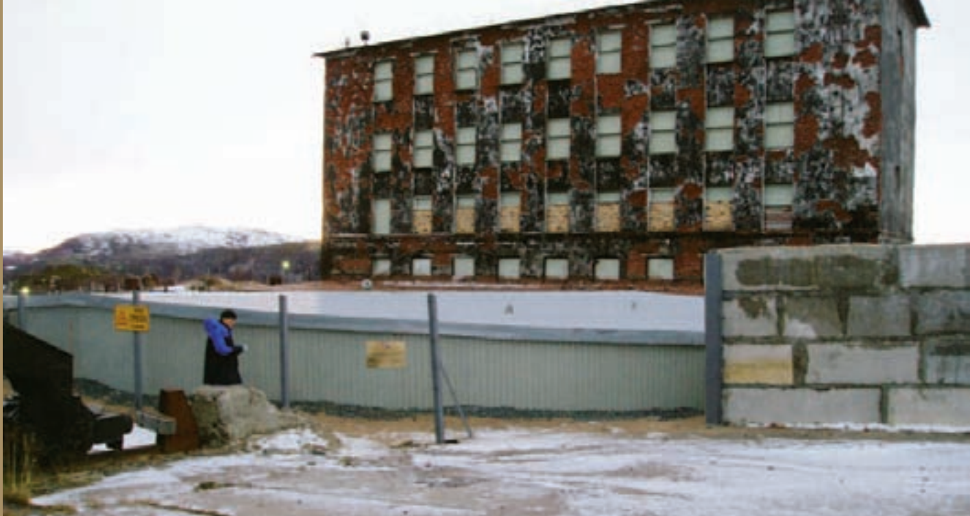
Пункт сухого хранения ОЯТ. Фото: НРПА.
