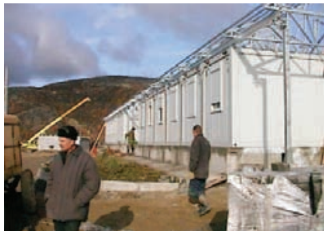
Возведение административного здания. Фото: администрация губернии Финнмарк.
