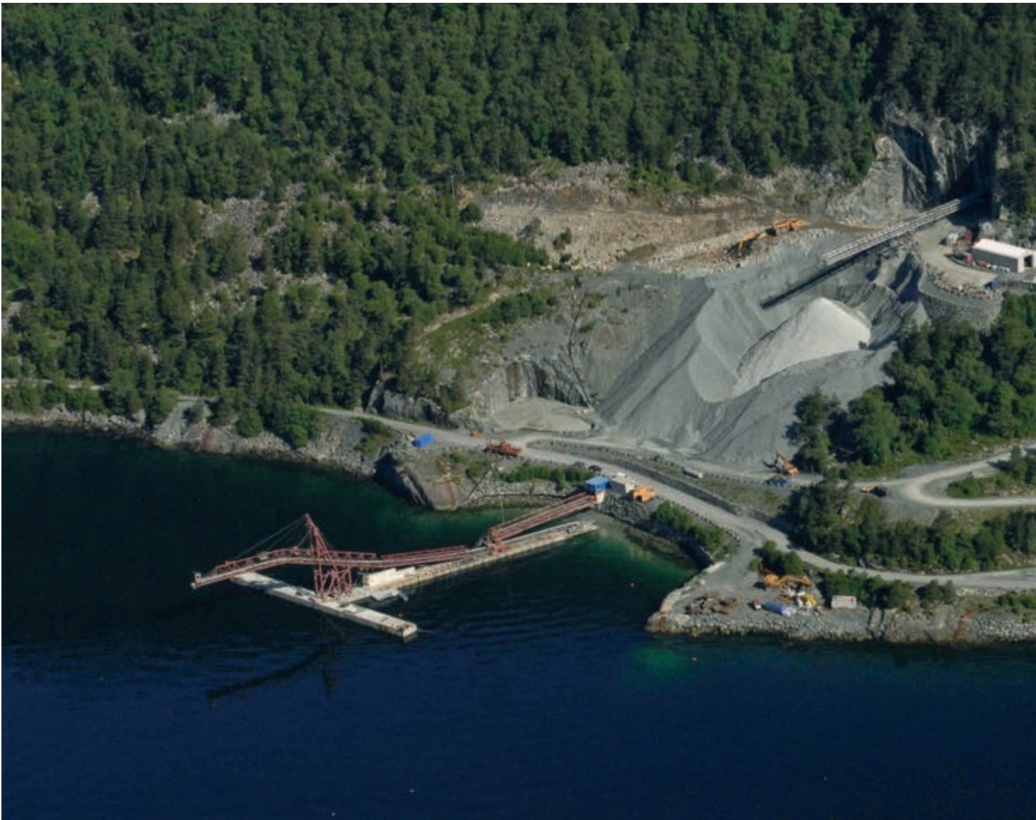
Bremanger Quarry i Sogn og Fjordane eksporterte i 2011 3,3 mill. tonn pukk til blant annet Nederland og Belgia. Bedriften har en CO 2 -vennlig knusemetode som involverer å slippe steinen fra 200 meters høyde inne i fjellet. Her fra anlegget på Dyrstad ved Svelgen. Foto: Bremanger Quarry
