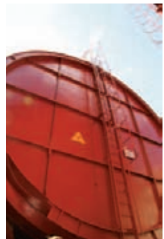
Lagring av reaktorseksjoner på landanlegget i Sajdabukta. Foto: Statens strålevern.
