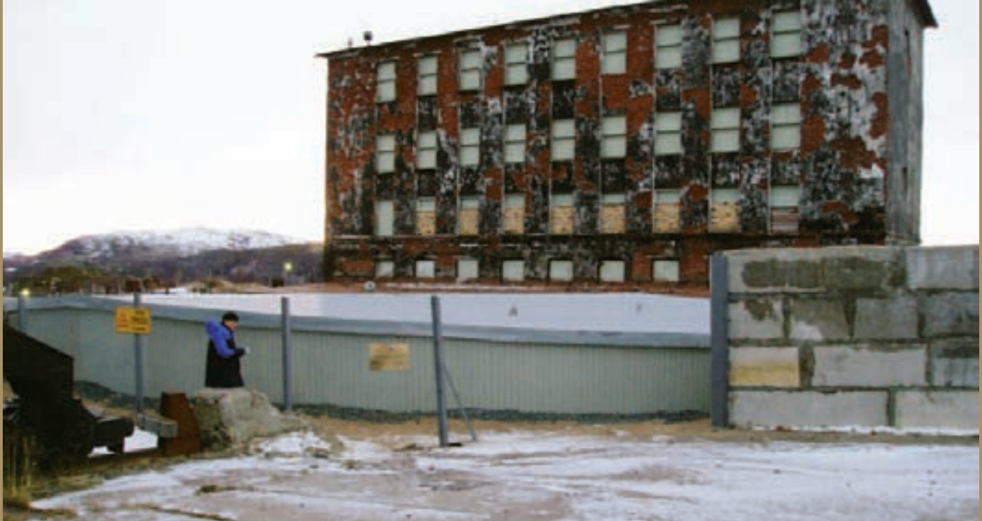
Tørrlagringstank for brukt brensel. Foto: Statens strålevern.
