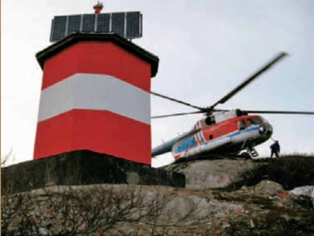
Fyrlykt med solcellepaneler. Foto: Fylkesmannen i Finnmark.
