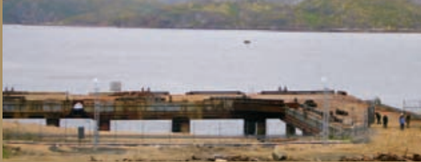
Kaianlegget i Andrejevbukta ble reparert i 2007-2008. Foto: Fylkesmannen i Finnmark.
