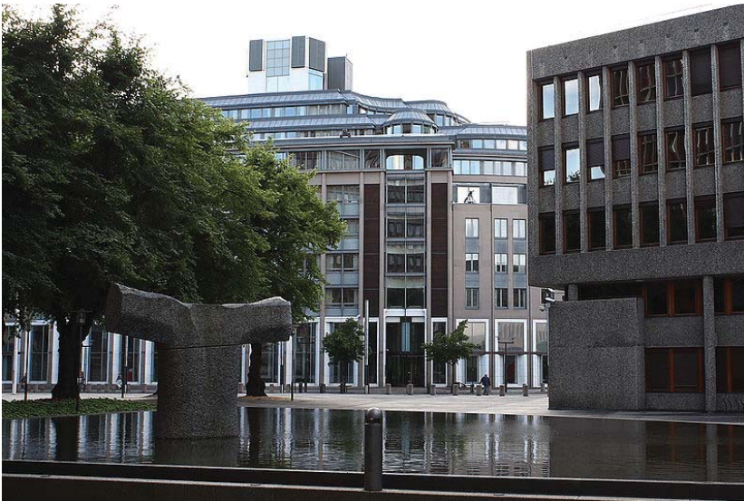
Inngangen til R5 ble plassert i aksen til den gamle linde alleen fra rikshospitalets tid. Foto: Alejandro Decap
