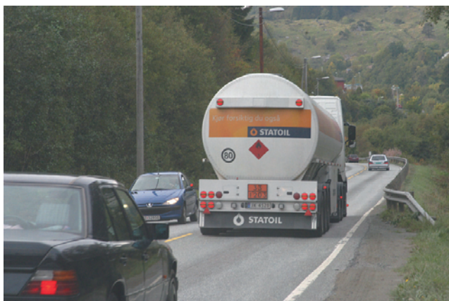
Fra dagens E39 ved Vikaleitet mellom Vågsbotn og Nordhordlandsbrua. En kortere strekning vil her erstattes med vedtatt Eikåstunnel. Foto Geir Brekke
