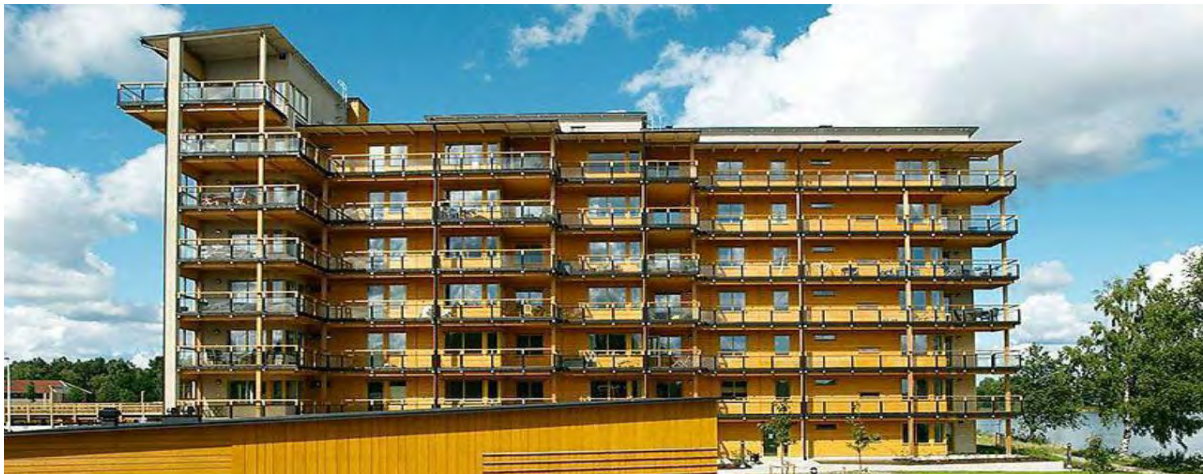
'Limnologen': 8-etasjes boligkompleks, Växjö, Sverige (Prosjektet 'Den moderna trästaden') (fra Rambøll 2012b).
