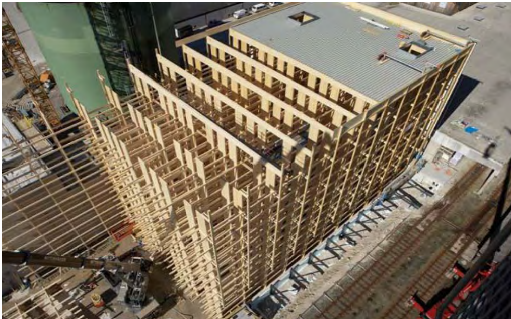
Foto fra anleggsperioden av næringsbygg for Salinen Østerrike AG, Ebensee. Eksempel på stor massivtrekonstruksjon (110 m lengde, 22 m bredde, 24 m høyde). Fra Rambøll (2012b).
