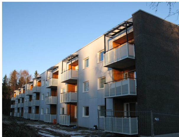
Fig. 6.1.2 Viser syvendt fasade etter oppgradering med bl.a. utvidede balkonger. Foto: SINTEF Byggforsk
